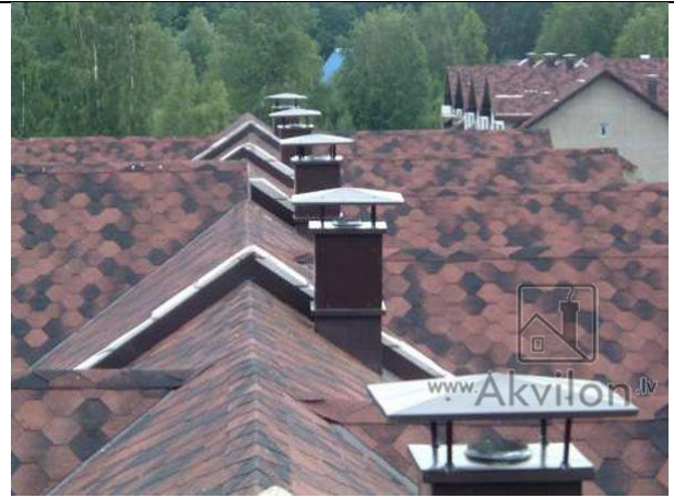
Ventilācijas izvadu, skursteņa jumtiņu ražošana, montāža
