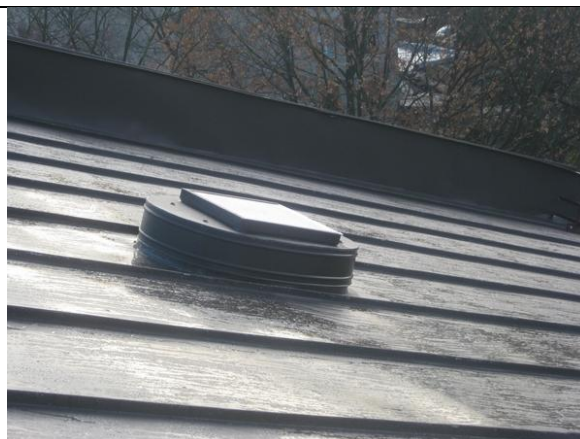
Jumta lūku, jumta papildelementu ražošana, montāža
