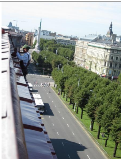
Ministru Kabineta ēkas jumta renovācijas darbi
