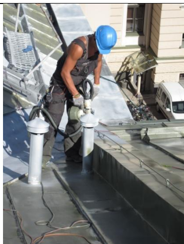
Latvijas Bankas ēkas jumta krāsošana, remonts
